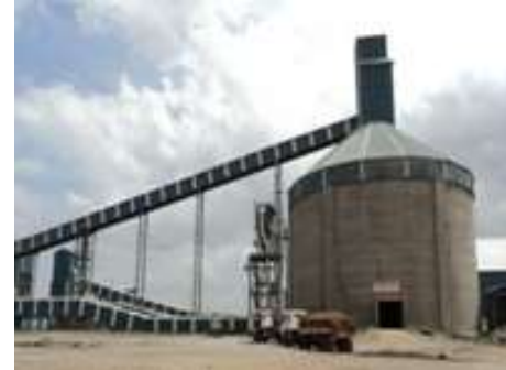
Clinker Silo (Cap: 60000 MT)
